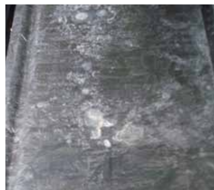
Le tracce bianche dovute alla formazione di carbonato basico idratato non influenzano la resistenza alla corrosione e sono il risultato della cosiddetta protezione galvanica.
