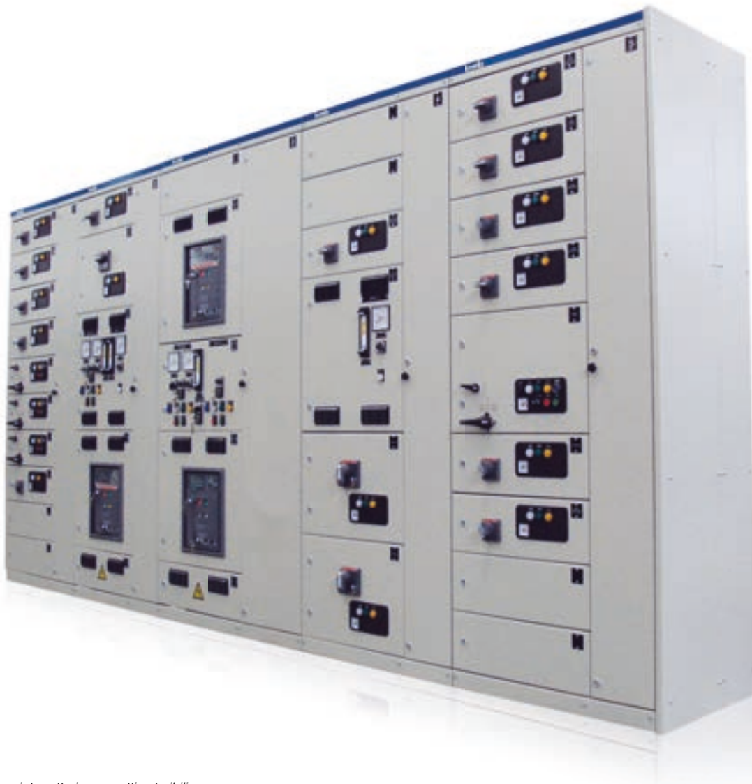
PMCC con interruttori e cassettei estraibili
