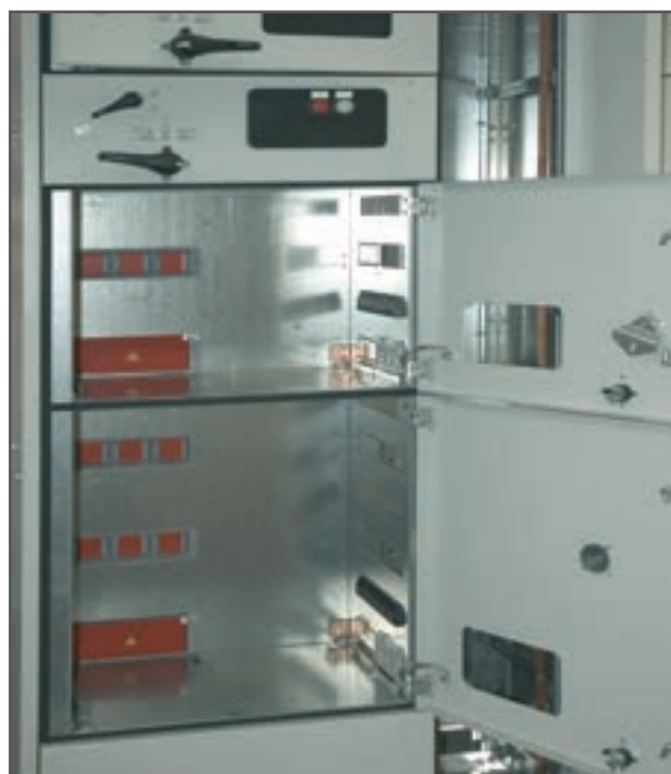
Allestimento cubicoli su quadri esistenti Preparation cubicle on existing switchboard Amenagement des cubicles sur tableaux existents
