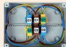
Piastrine segnaletiche per contrassegnare i circuiti. Covers are available to mark the circuits
