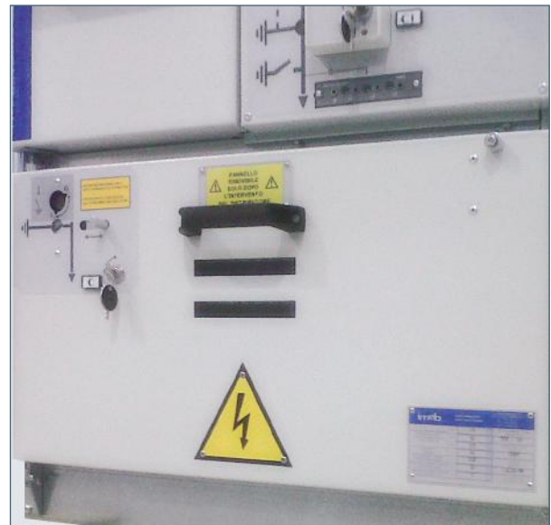
Terre in ingresso Incoming earthing switch Sectionneur de mise à la terre
